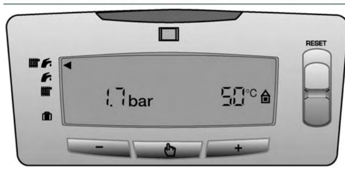
Figuur 7. Weergave display bij toepassing van een buitenvoeler
