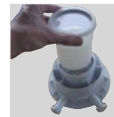
Installation du clapet anti-retour à l'intérieur de la buse
